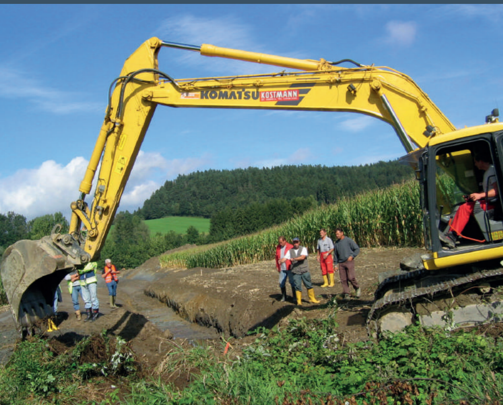
Naturschutzfachkräfte auf der Baustelle
