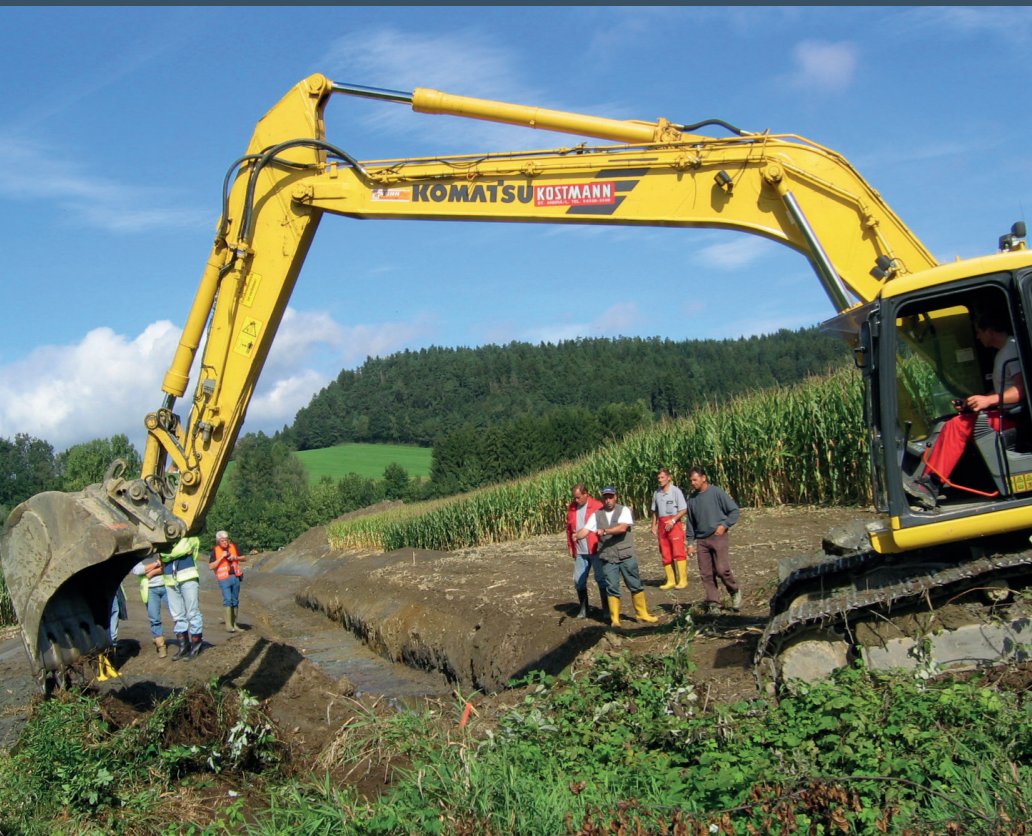
Naturschutzfachkräfte auf der Baustelle
